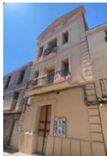
Il·lustració 23.- Edifici "La Creu"
