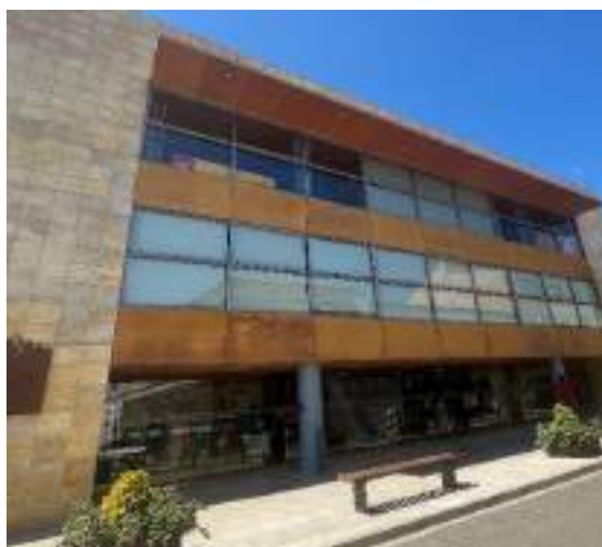
Il·lustració 14.-Edifici CCM "Lo Casino"
