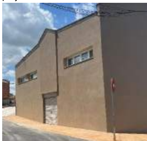
Il·lustració 48.-Edifici Sala de Ball de Sudanell
