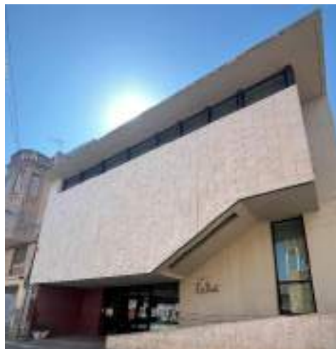
Il·lustració 27.- Instal·lació plaques solars al Centre Cívic "Lo Ball"
